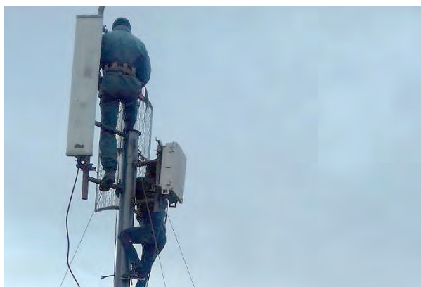
Насби таҷҳизоти GSM-и системаи IT-70 Установка оборудования GSM системы IT-70
